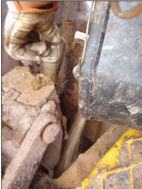
Figura 3-7 - Lançamento da areia para confecção da célula de areia.
