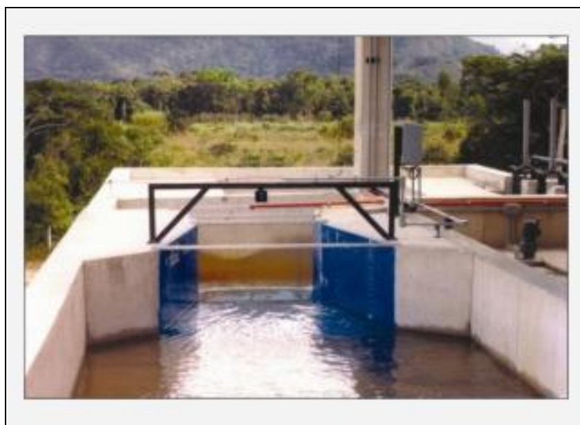
Figura 2-34 – Exemplo de vertedor retangular (Fonte: Website Sanecomfibra)
