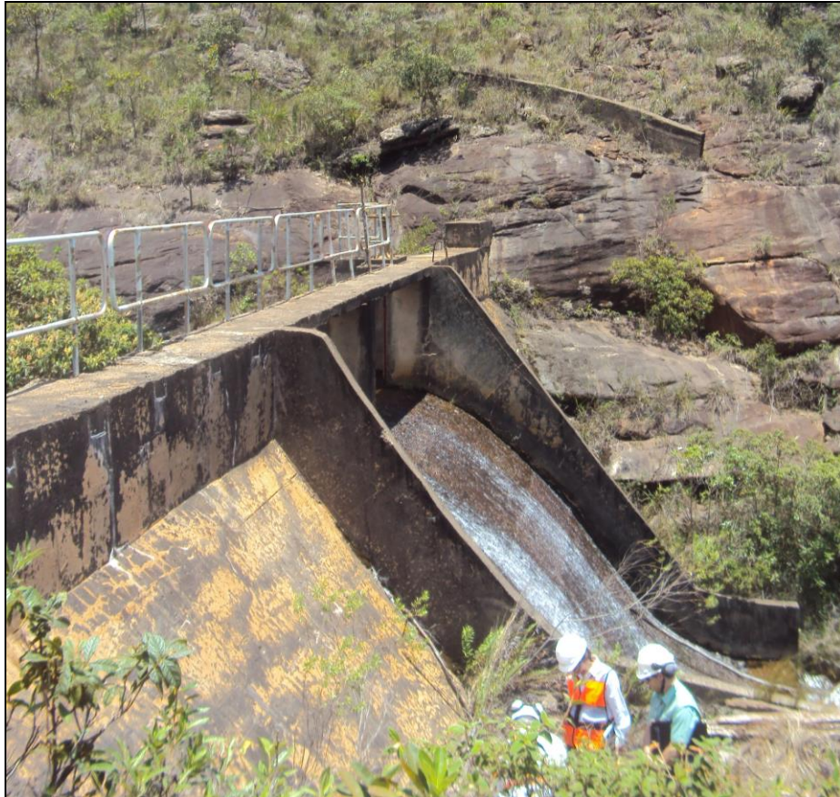
Figura 2-5 - Barragem de captação de água da Mina Capanema/MG (Fonte: O autor, 2014)
