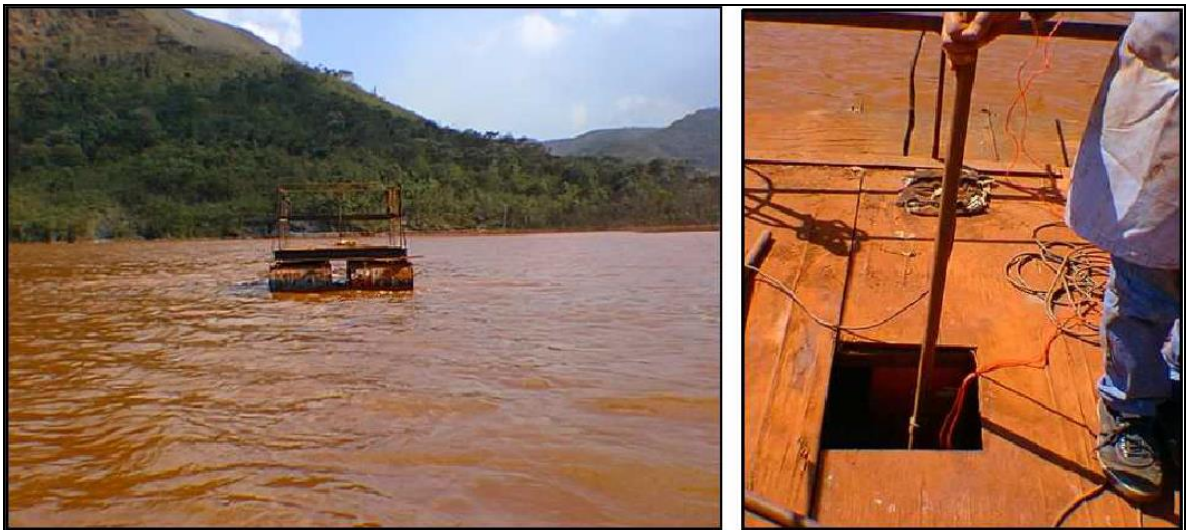
Figura 3-12 - Sondagem piezométrica em lama depositado no fundo de reservatório (Fonte: Notas de aula "Disposição de resíduos de mineração – Aula 7: Engenharia de Disposição de Rejeitos" UFOP, 2014).
