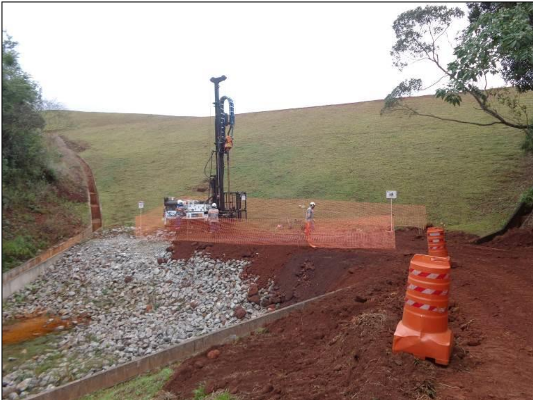
Figura 3-6 - Praça de sondagem com furo executado em fundação de barragem (Barragem Principal da Mina Capanema – Fonte: O autor, 2015).
