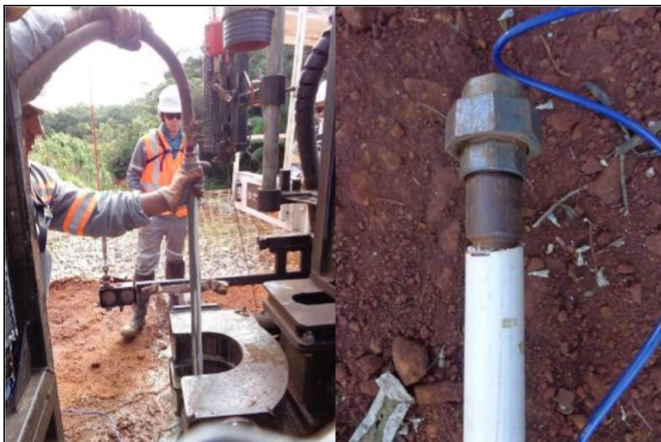
Figura 4-18 - Injeção de graute sob baixa pressão e detalhe da conexão da mangueira (Fonte: O autor, 2015).
