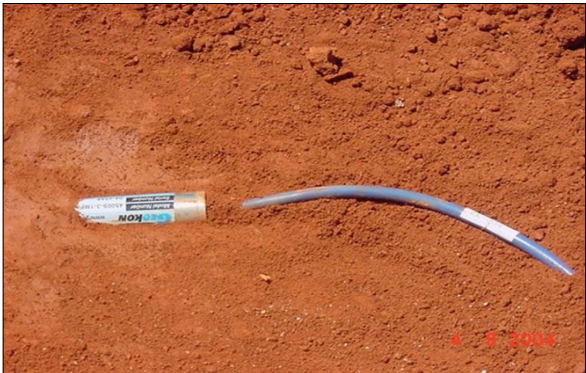
Figura 4-13 - Sensor piezométrico instalado durante construção do aterro (Fonte: Yassuda, 2008).
