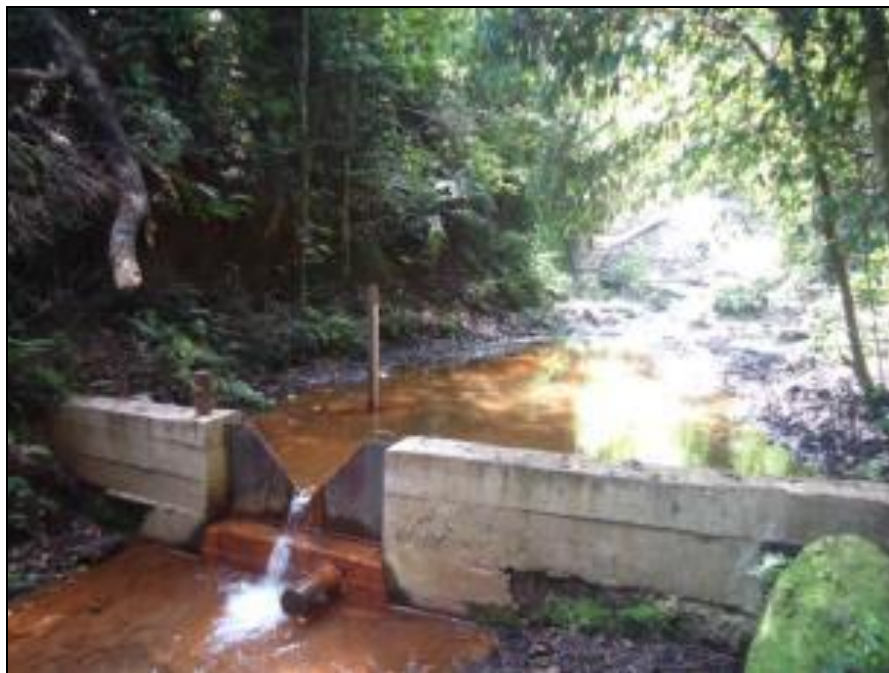
Figura 2-32 – Exemplo de placa de aço do vertedor triangular (Fonte: O autor, 2016)
